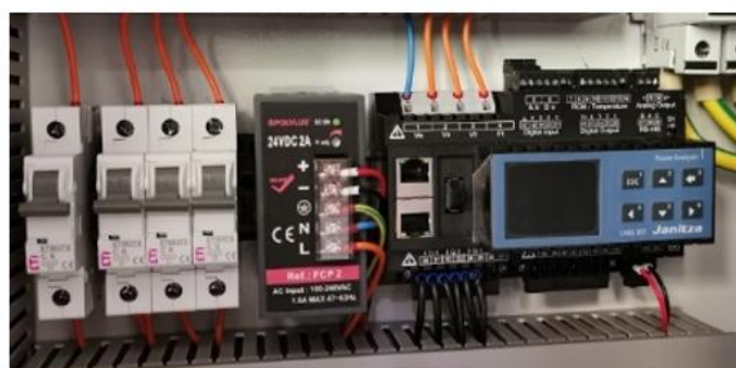
Slika 4: Prikaz meritev polnjenja avtobusov na postaji Vzpenjača z napravo Janitza UMG 801 [lastni vir]
